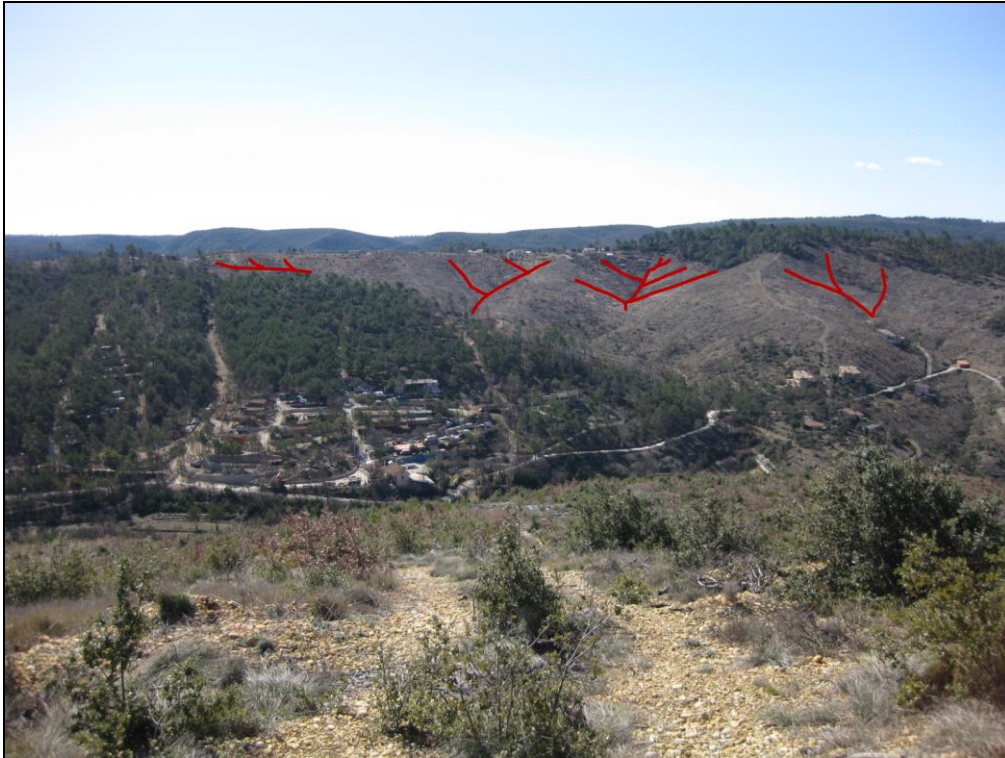
Figure 27 : Ravinement dans le secteur des Quartons [Source : IMS RN ]
