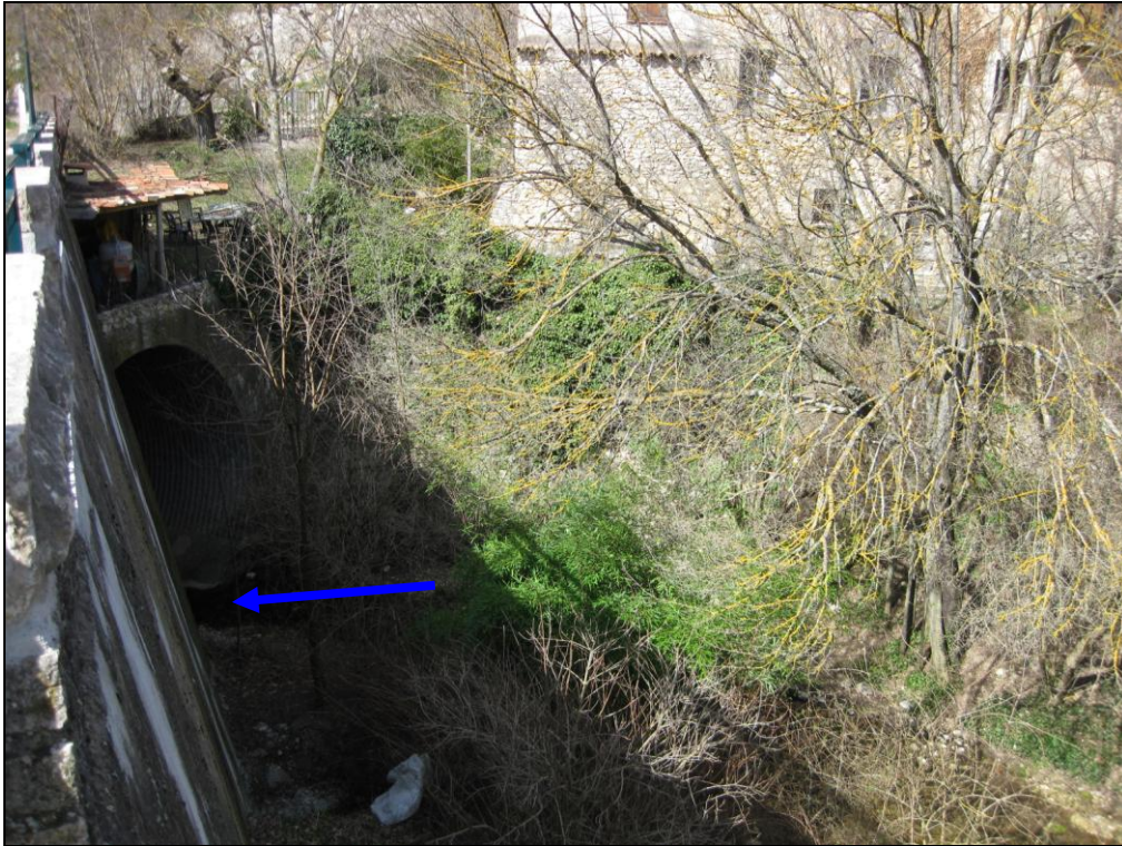
Figure 47 : Torrent d'Albosc, passage sous la RD 82 [Source : IMS RN ]
