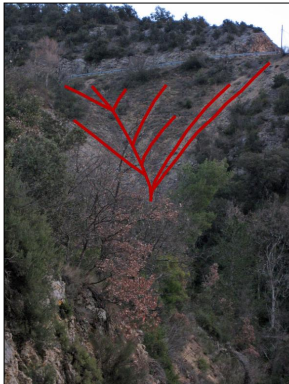
Figure 28 : Ravinement dans le secteur du barrage [Source : IMS RN ]
