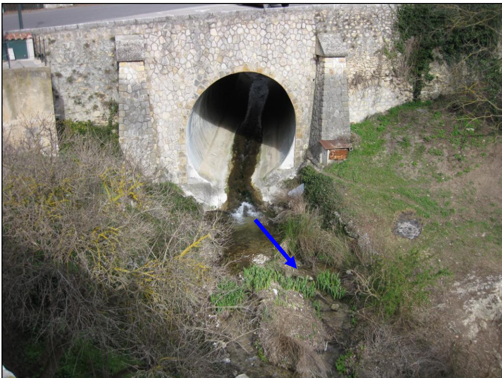
Figure 48 : Torrent d'Albosc, passage sous la RD 82 [Source : IMS RN ]
