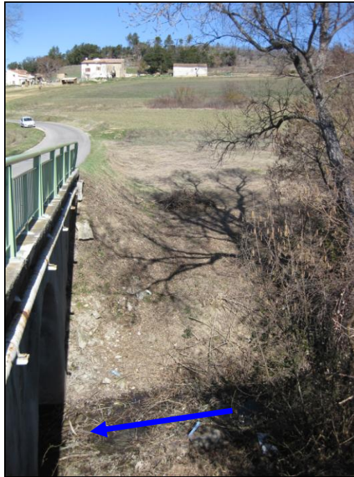
Figure 54 : Torrent de Bellieux, passage sous la RD 82, au niveau de Chautabri [Source : IMS RN ]
