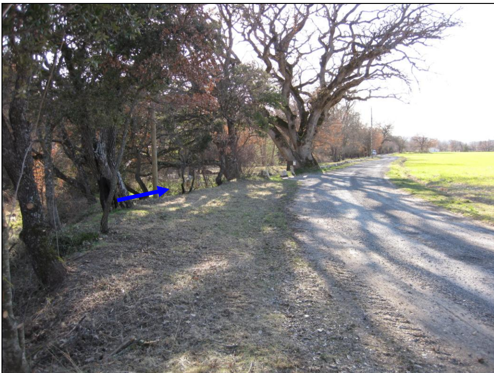
Figure 51 : Torrent de Bellioux, au niveau de Bellioux [Source : IMS RN ]
